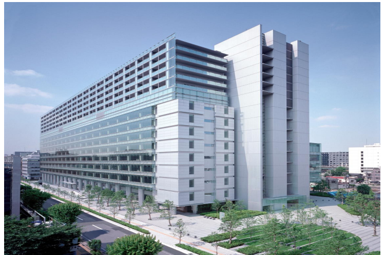
飯田橋ファーストビル
