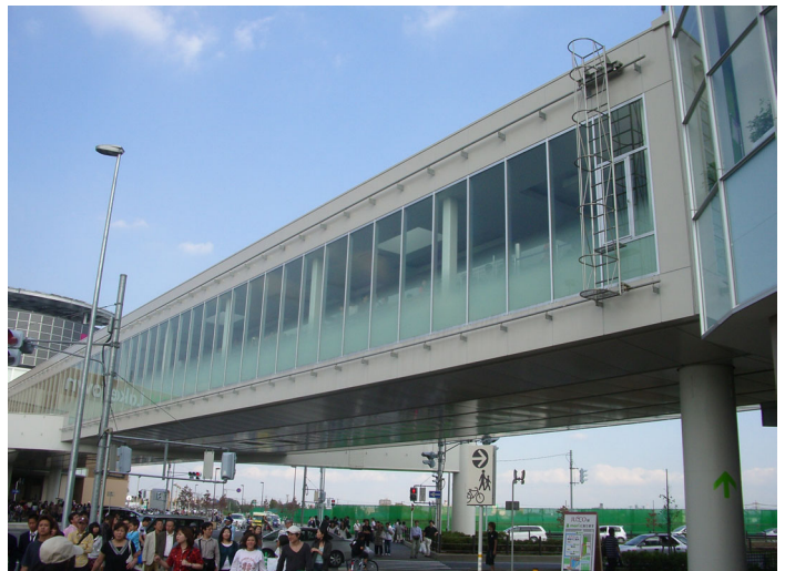
A1区とB1区をつなぐブリッジ
